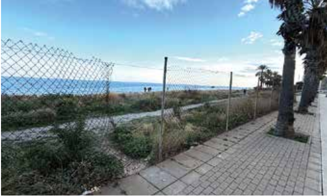
Tanques rovellades a la Mora
