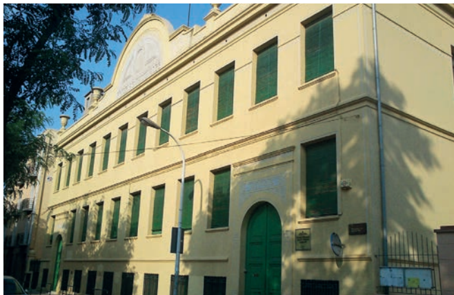
Imatge exterior de l'escola Ventós Mir, al Centre.
