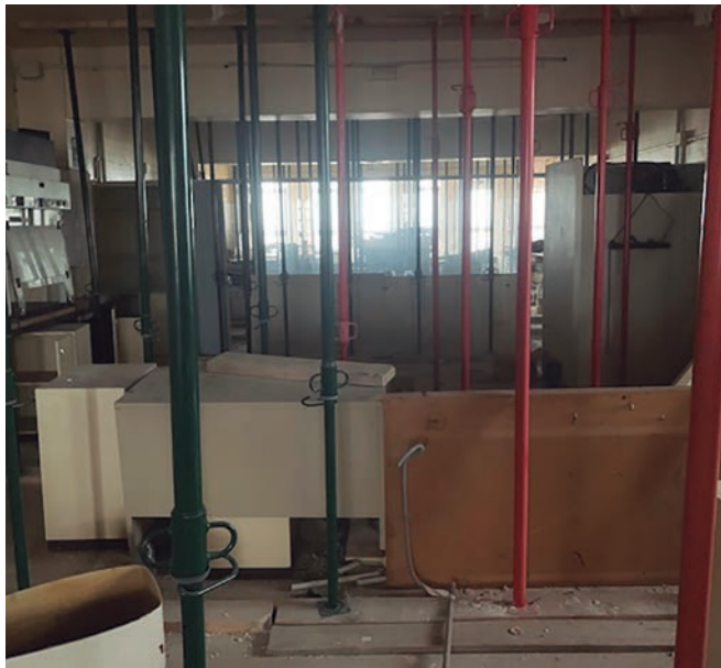
Imatge de l'anterior de l'edifici del mercat del Peix
