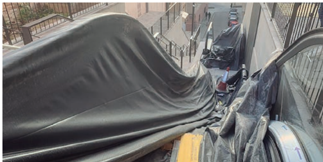
Imatge de les rampes del carrer Fortuny, a Sant Crist
