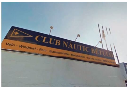
El Club Nàutic Bétulo rep una notificació per enderrocar les seves instal·lacions
