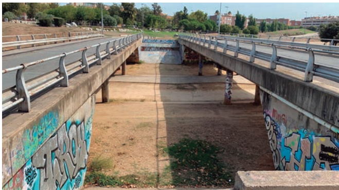
Un dels ponts del barri de Montigalà on es farà la diagnosi
