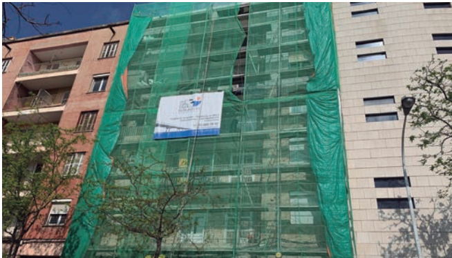
Una de les darreres bastides instal·lades a la Via Augusta
