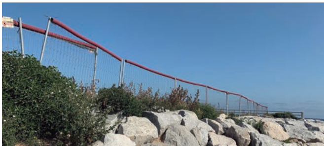
Les tanques resten instal·lades des del passat estiu
