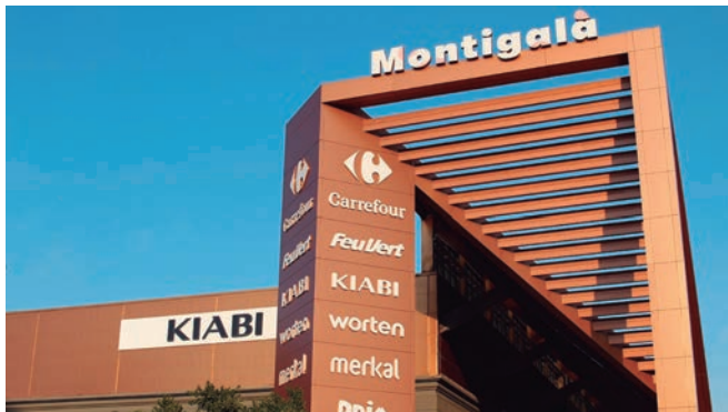
Imatge exterior del Centre Comercial Montigalà
