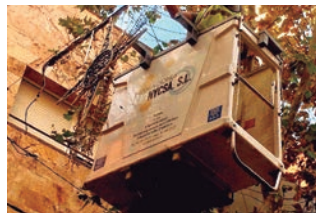
El carrer d'en Prim ja té els llums instal·lats, des d'aquest dilluns
