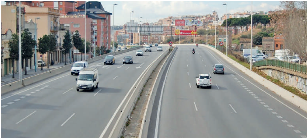
La Generalitat asfaltarà l'autopista amb un innovador paviment que redueix les emissions
