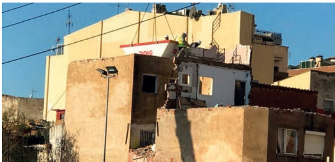
Imatge de l'edifici del Passatge de la Torre, aquest dilluns
