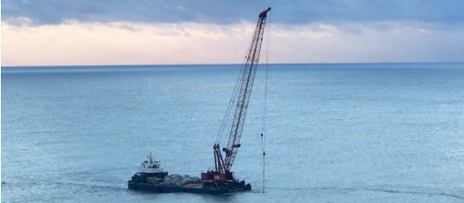
Imatge de la gran grua que treballa al dic Recer del Port
