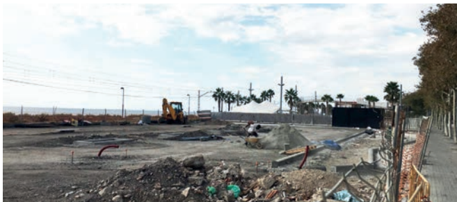
Imatge del solar de Canyadó on s'hi fan les obres
