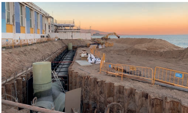
Imatge de les obres de trasllat del col·lector de llevant
