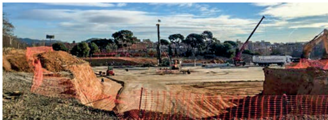
Imatge del solar on s'està construint el Bricomart
