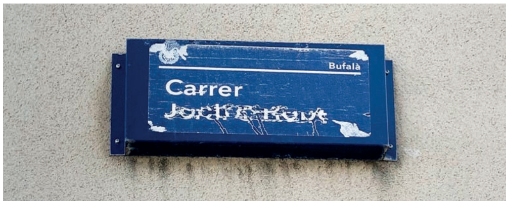
Una placa en mal estat a Bufalà
