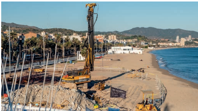
Imatge de les obres a la platja del Patí de Vela
