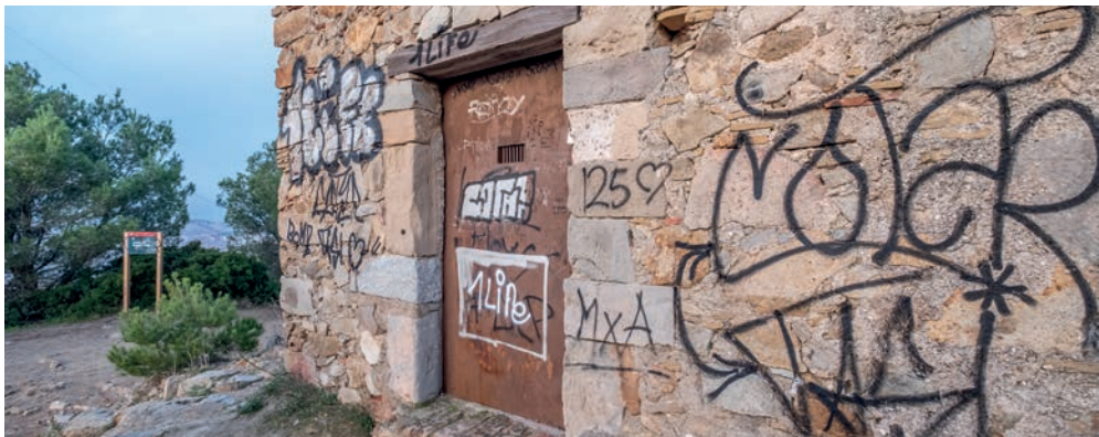
Porta d'entrada de l'Ermita de Sant Climent, aquest dimarts
