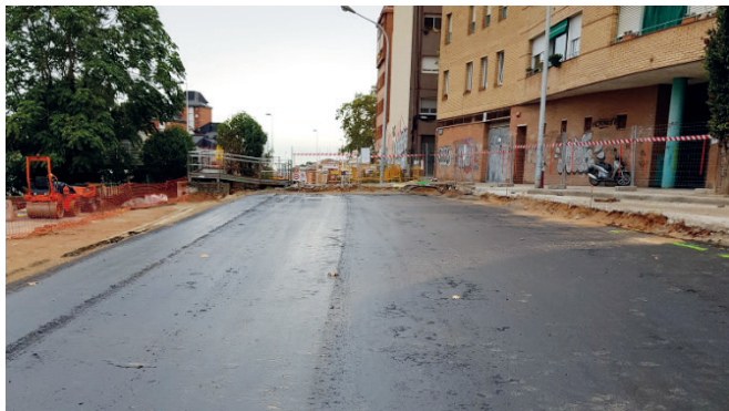
Imatge de les obres del lateral al pas per Bufalà
