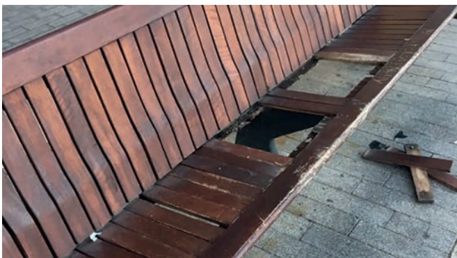
Imatge d'un dels bancs deteriorats de la Rambla
