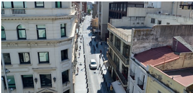
Al carrer Francesc Layret s'estan fent millores en el paviment
